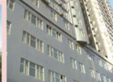
河北石家庄中铁大厦
